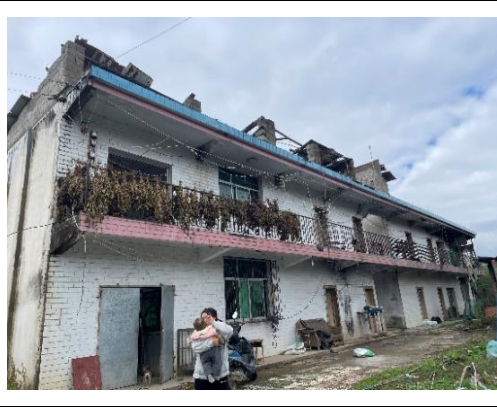
秦岭沟村陈某家
